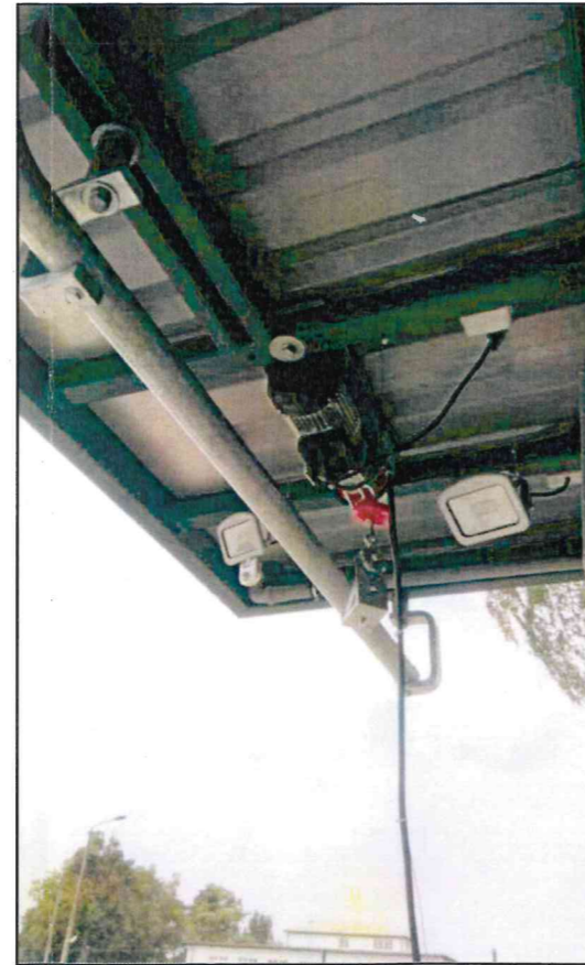
Rollbahn mit Vordach
