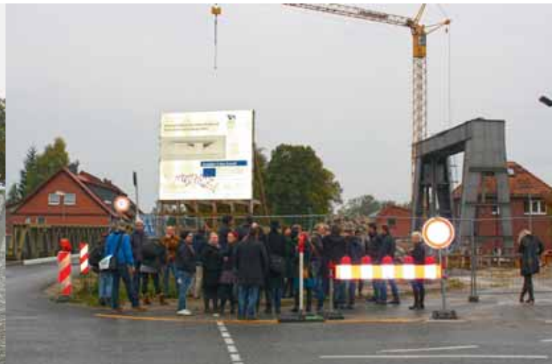
Baustelle »An der Schleuse«
