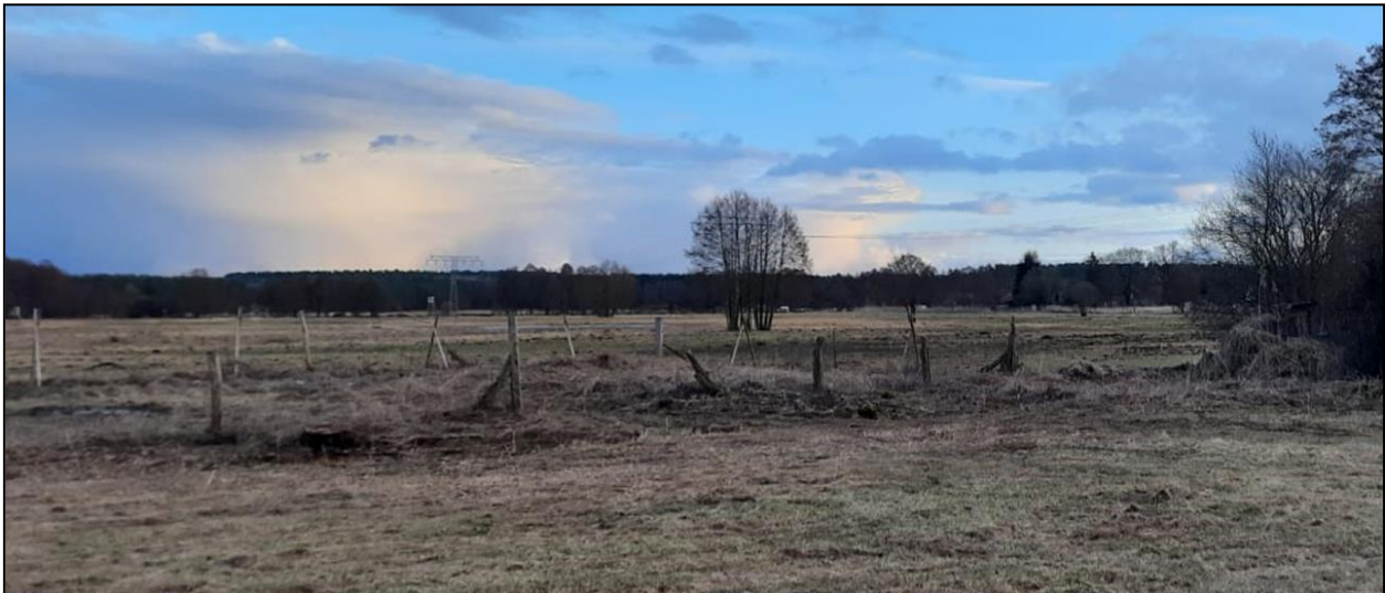
Abbildung 5: Blick aus dem nördlichen Baufeld in Richtung Osten, Baukonzept Neubrandenburg GmbH, März 2021
