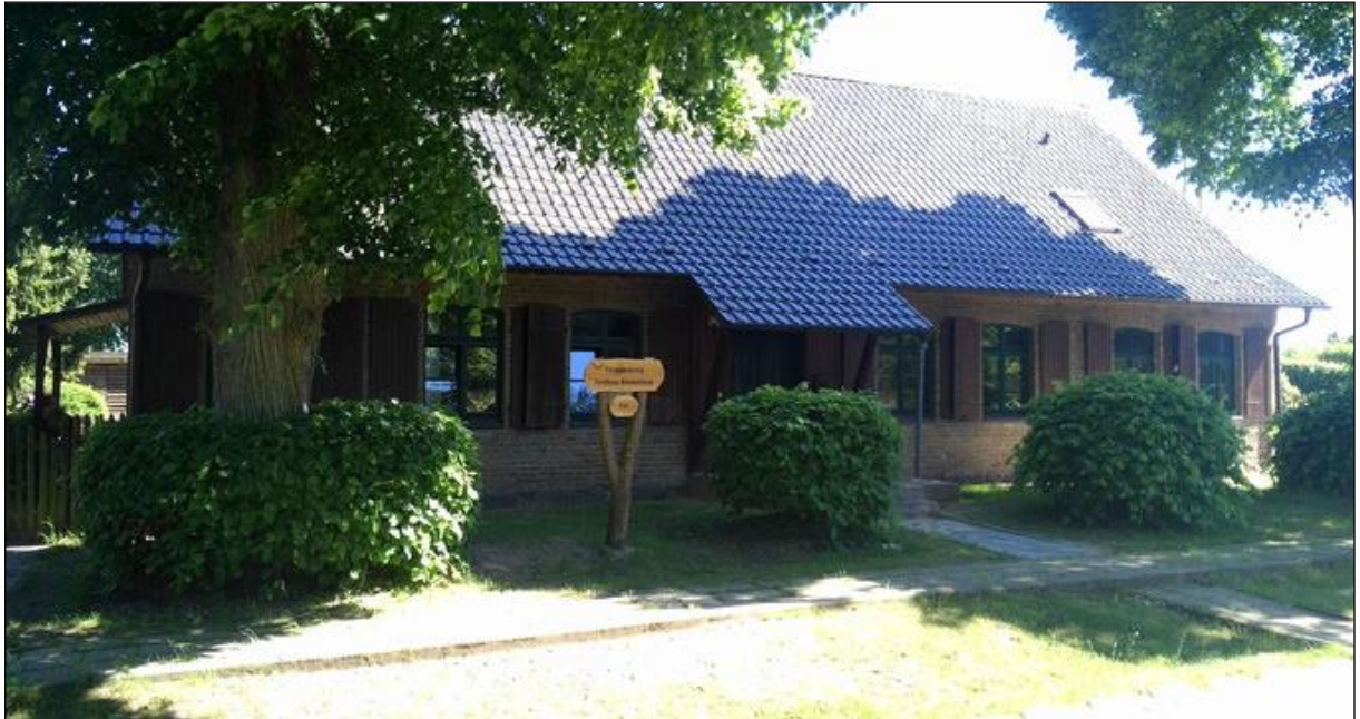
Abbildung 1: ehemalige Försterei als denkmalgeschütztes Bestandsgebäude
