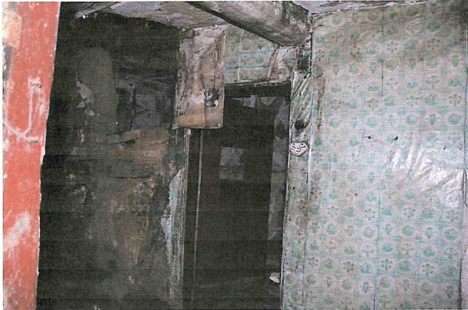
Ansicht in den hinteren Teil des Gebäudes
