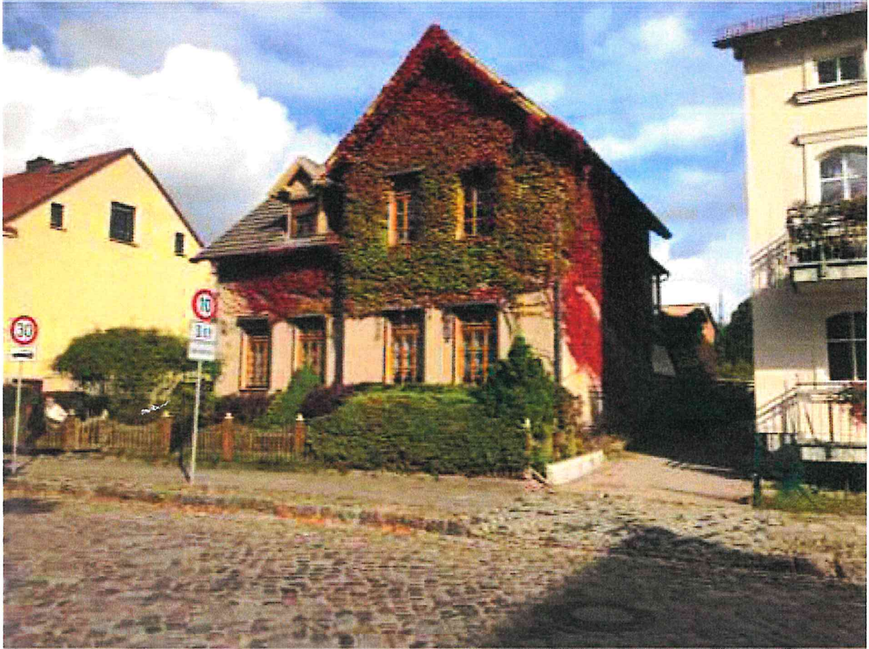
Wohnhaus und Remise im Bestand - Straßenansicht
