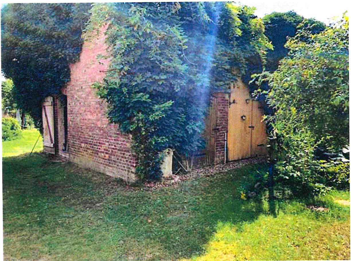
Remise im Bestand – Ansicht Nordwestecke
