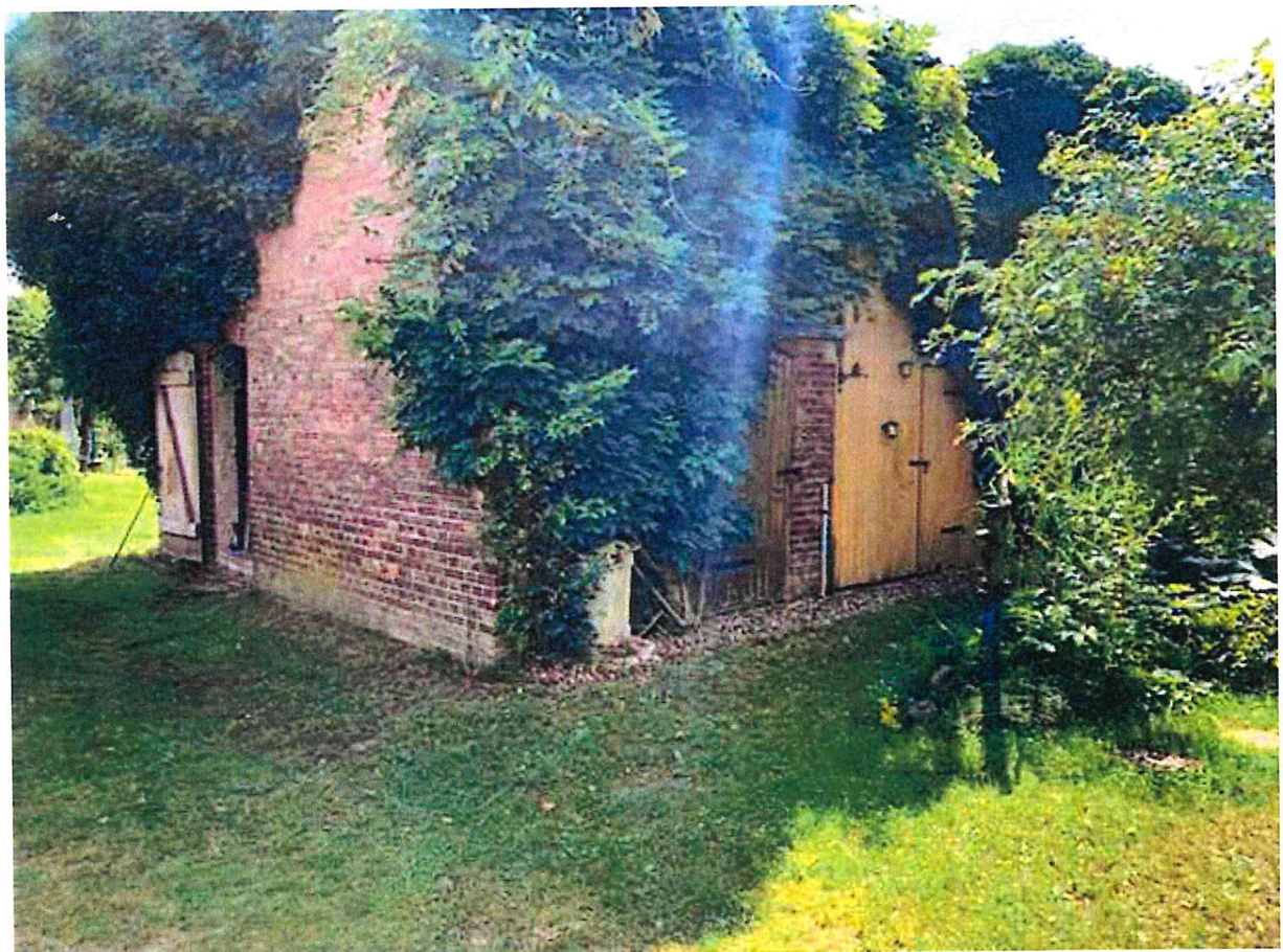
Remise im Bestand – Ansicht Nordwestecke
